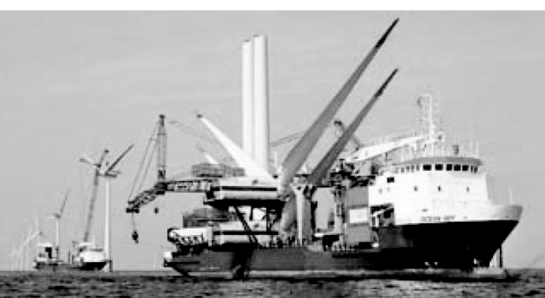
写真5 洋上風力発電施設の建設：英国では洋上施工専用船を建造し、建設コストの低減と施工効率の向上に成功した。
