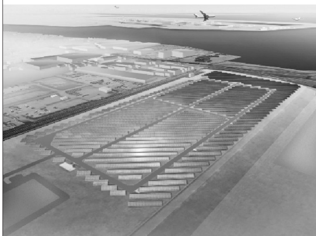
図4 2009年11月に発表された東京電力のメガソーラー発電プラント「浮島太陽光発電所 (仮称)」。発電出力は約7MW、プロジェクト全体を東芝が一括受注した。
