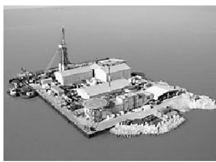
写真1 国際石油開発帝石(株)が参加しているカスピ海のカシャガン油田開発井掘削基地
