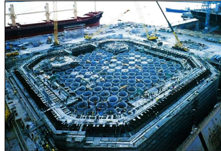
ハニカム構造の施工写真（上空から）
